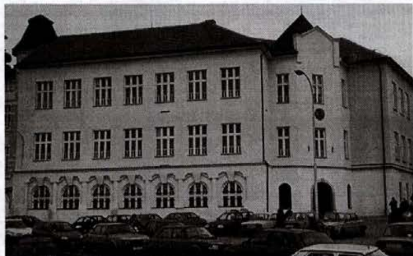
Budova Gréckokatolíckej bohosloveckej fakulty PU
